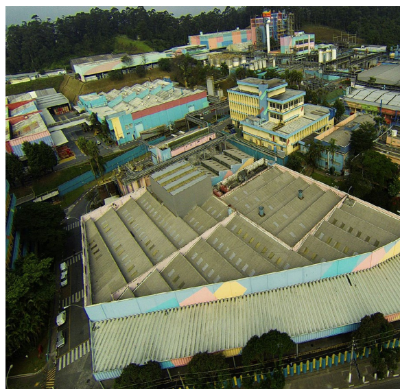
Complejo industrial de pinturas y barnices de BASF en São Bernardo do Campo (SP, Brasil).
